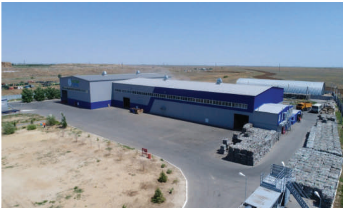
Рис. 11.1. Объект обработки ТКО г. Волжский
