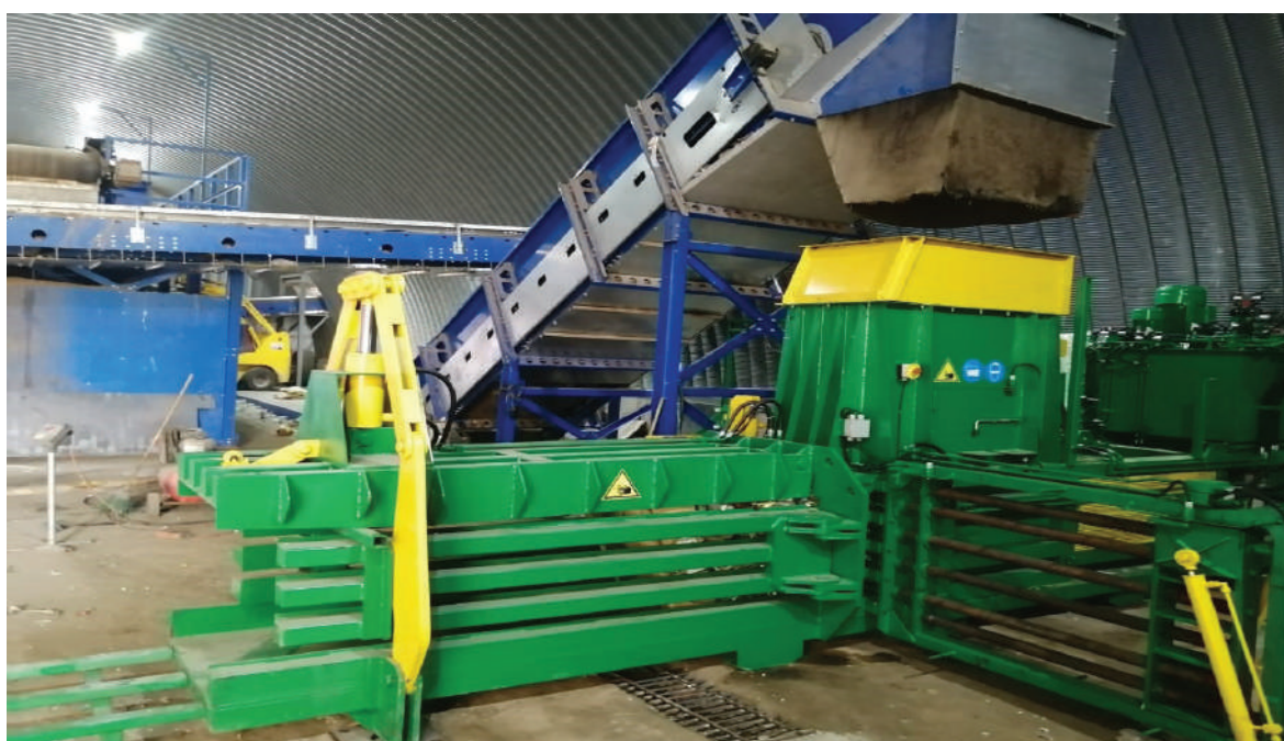
Рис. 11.2. Объект обработки ТКО г. Камышин
