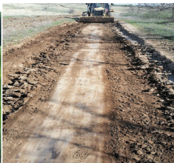
Рис. 10.10. Дороги противопожарного назначения, Красноармейское участковое лесничество
